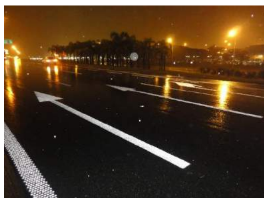
ROD. HÉLIO SCHIMITH - GUARULHOS Pintura de relevo sob chuva
